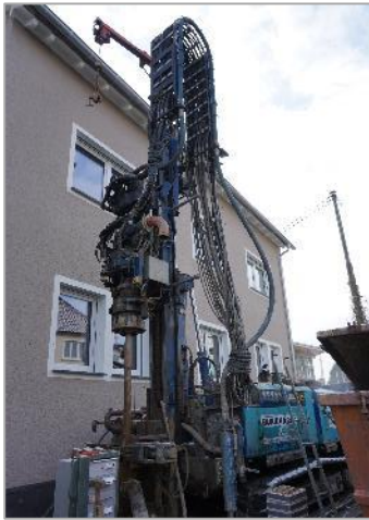
Erdsondenbohrungen
